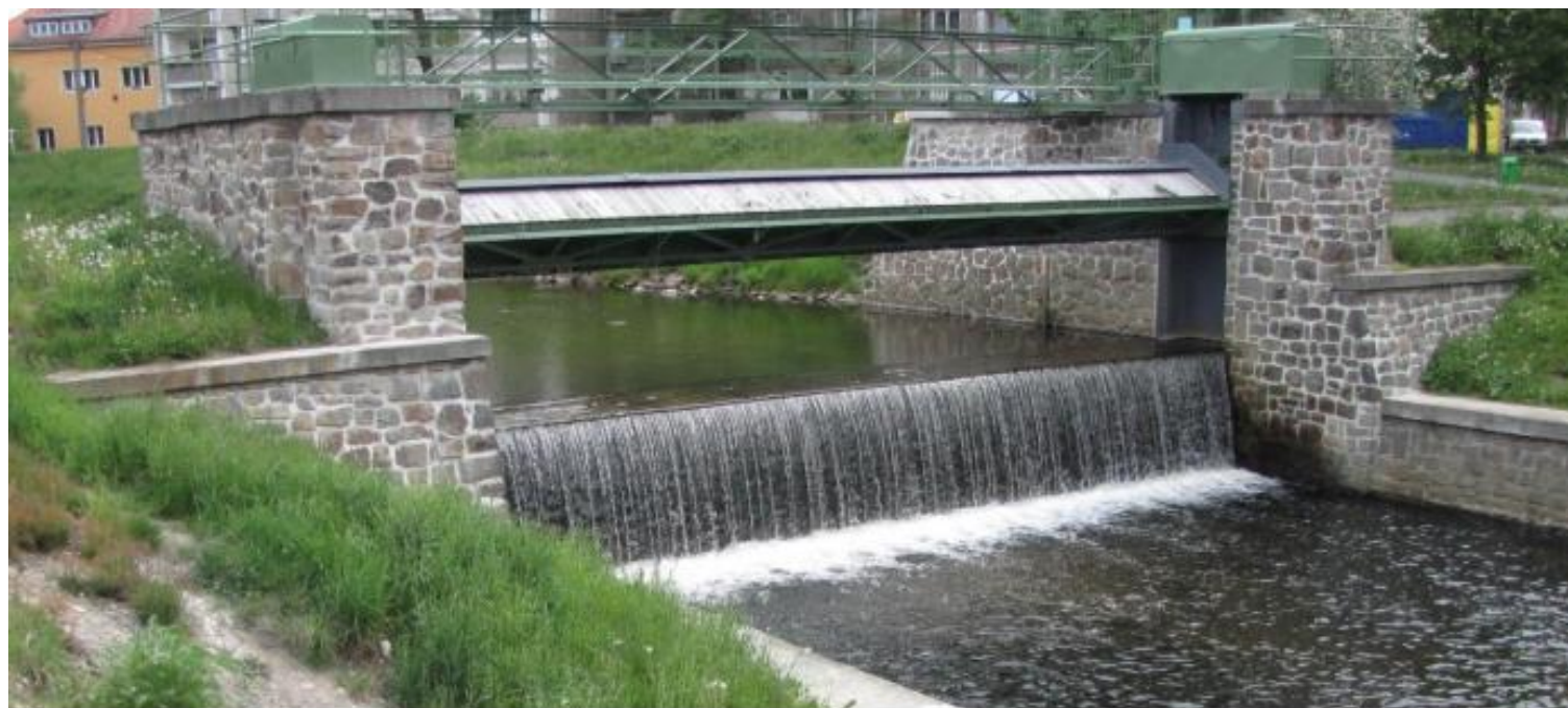
celkový pohled na jez
