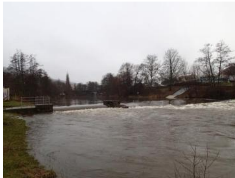
celkový pohled na jez
