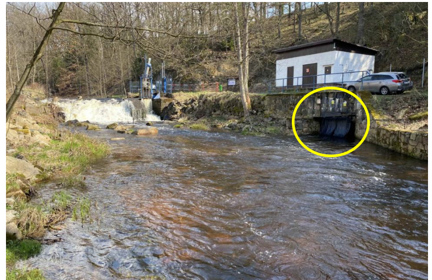
odpadní kanál MVE
