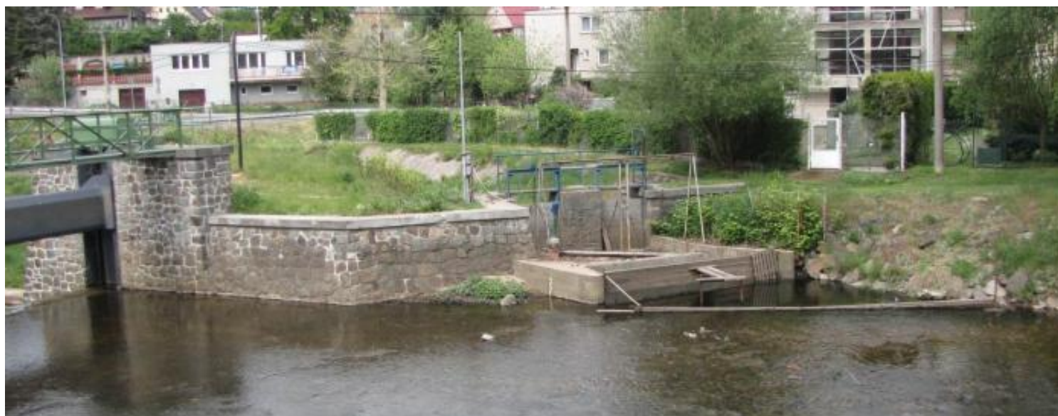
PB v nadjezí se vtokovým objektem do náhonu
