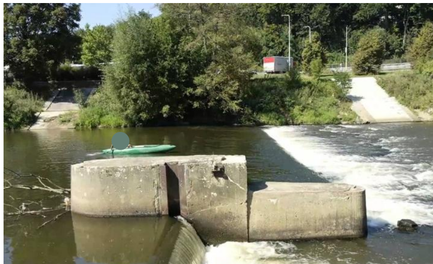
pohled na LB – umístění RP, schody v nadjezí budou demontovány, v podjezí zachovány
